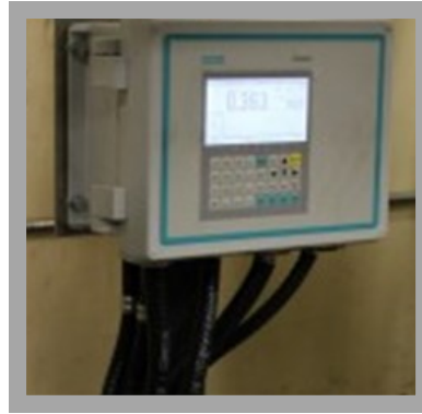
Siemens Hot Water Meter
